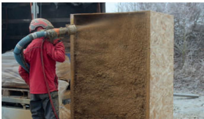
Test de fonctionnement du matériau isolant et de la machine à insuffler
